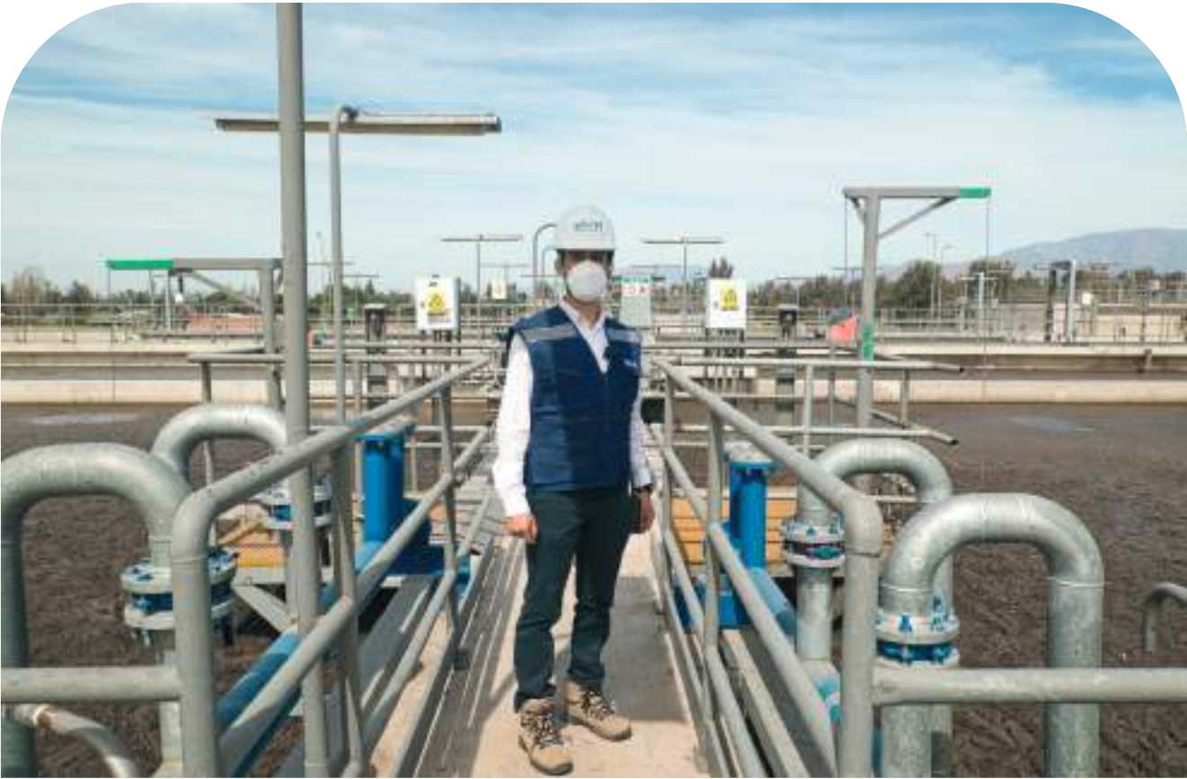
Estación depuradora de aguas de Batuco, Chile
