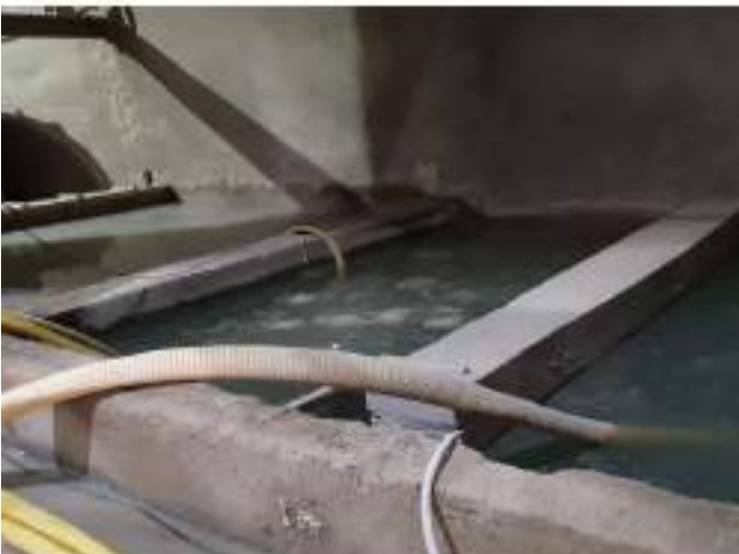
Américo Vespucio Oriente (AVO): Sistema de decantación y floculación/coagulación
