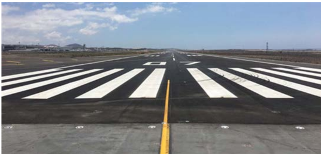
Pista repavimentada Aeropuerto Tenerife Sur
