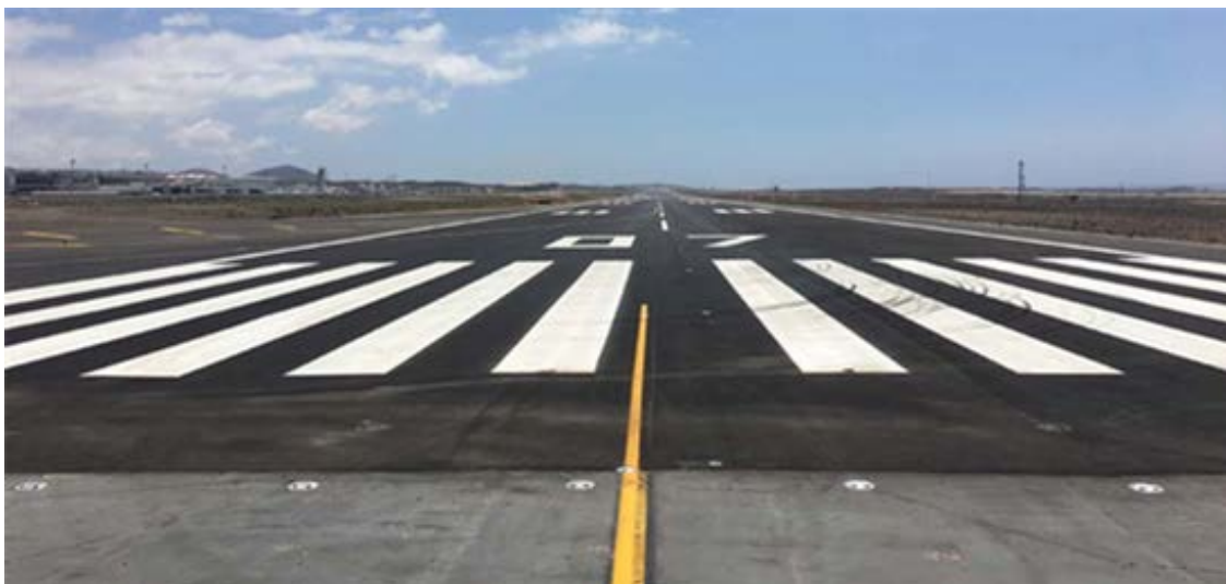
Pista repavimentada Aeropuerto Tenerife Sur
