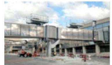
Imagen 27. Nuevas pasarelas en el aeropuerto de Málaga
