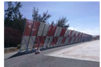
Imagen 19. Barreras anti-chorro. Aeropuerto de Gran Canaria
