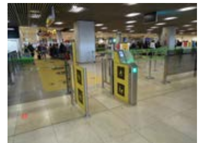
Imagen 14. Instalación de accesos PMR en los controles de T1 y T4 del aeropuerto de Madrid
