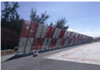
Imagen 20. Barreras anti-chorro. Aeropuerto de Gran Canaria
