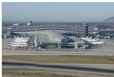
Imagen 2. Plataforma - Aeropuerto Barcelona-El Prat
