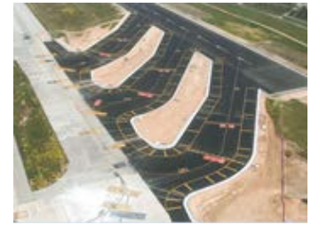
Imagen 18. Nuevas calles de acceso. Aeropuerto de Palma de Mallorca
