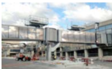
Imagen 28. Nuevas pasarelas en el aeropuerto de Málaga
