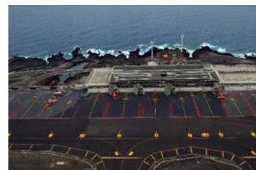
Imagen 4. Vista aérea - Aeropuerto de La Palma
