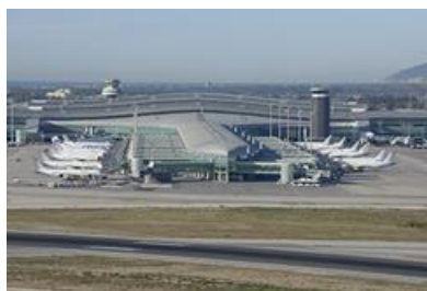
Imagen 2. Plataforma - Aeropuerto Barcelona-El Prat
