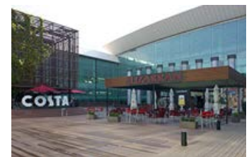
Imagen 33. Restauración en el Aeropuerto Barcelona-El Prat
