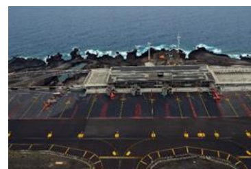
Imagen 4. Vista aérea - Aeropuerto de La Palma
