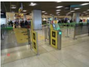
Imagen 15. Instalación de accesos PMR en los controles de T1 y T4 del aeropuerto de Madrid
