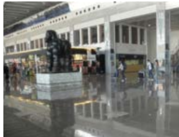
Imagen 12. Renovación de pavimento en el hall de la T2B del aeropuerto de Barcelona
