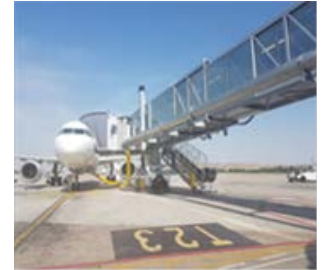
Imagen 26. Nueva pasarela. Aeropuerto Adolfo Suárez Madrid-Barajas
